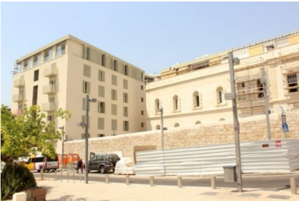
Chantier de construction des « Résidences de Tel Aviv »
