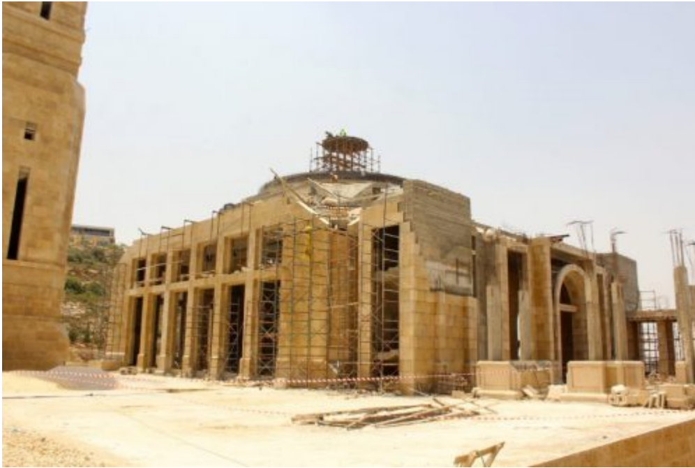
La mosquée de Rawabi en construction.
